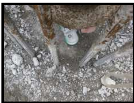
انجام آزمایش سلامت شمع بیروی شمع های برج ایزدشهر کارفرما: مهندس یزدانی
